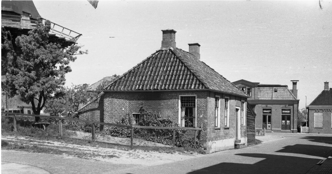
De sarrieshut met de zuid- en oostgevel. Foto gemaakt door W.O. Bakker in 1951.
